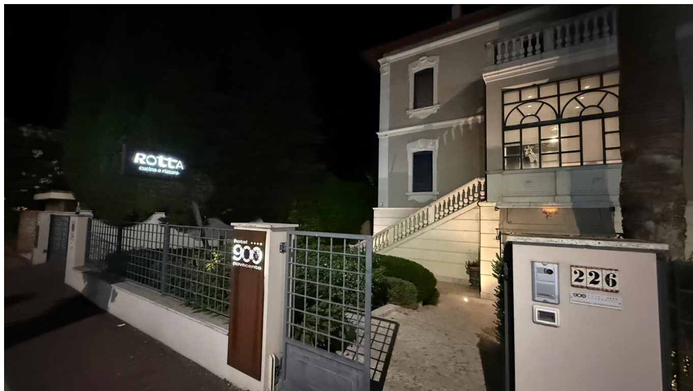
L'ingresso di Rotta
